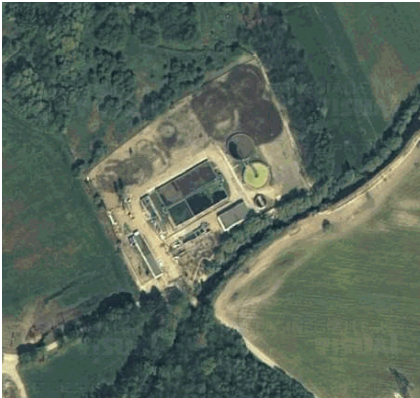
Figura 3.4: Foto aerea del Depuratore di Casalzuigno
